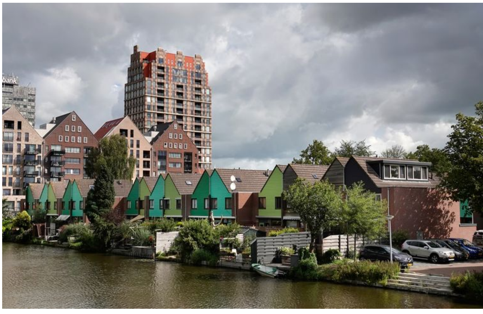
Stadsvernieuwing Inverdan. Woontoren de Tsaar aan de Hermitage in Zaanadam. Beeld Hollandse Hoogte
